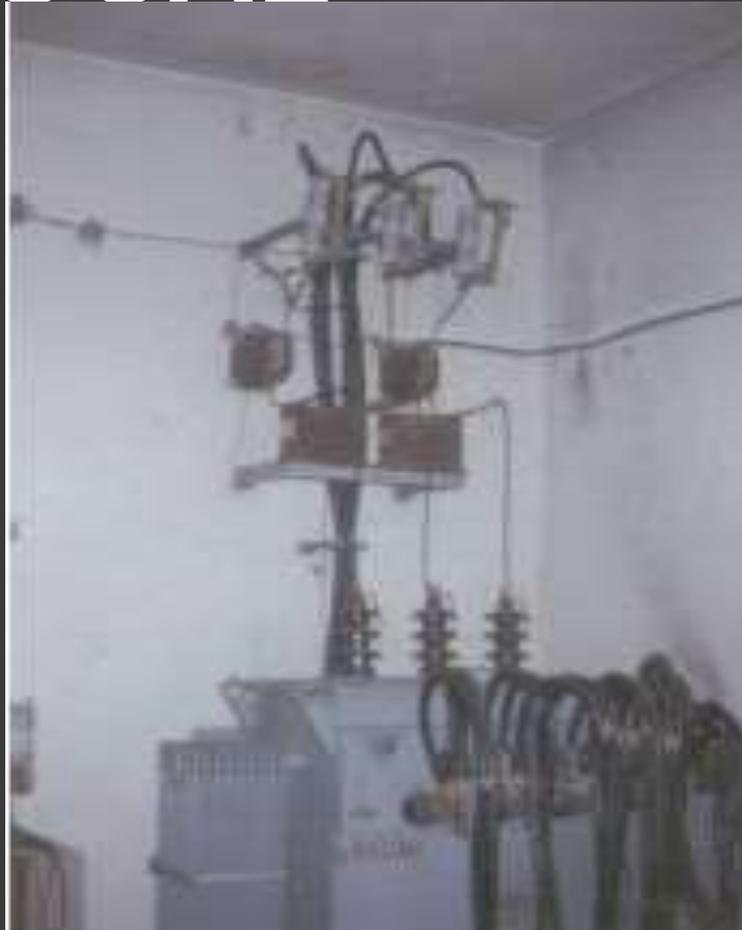
Las subestaciones tipo local en la actualidad no son permitidas, debido al peligro latente al que esta expuesto el personal, ya que tanto el transformador de distribución, los seccionadores de operación bajo carga o el barraje, se encuentran a la vista en el interior de un recinto cerrado de 3.5X2.5X3 m.
