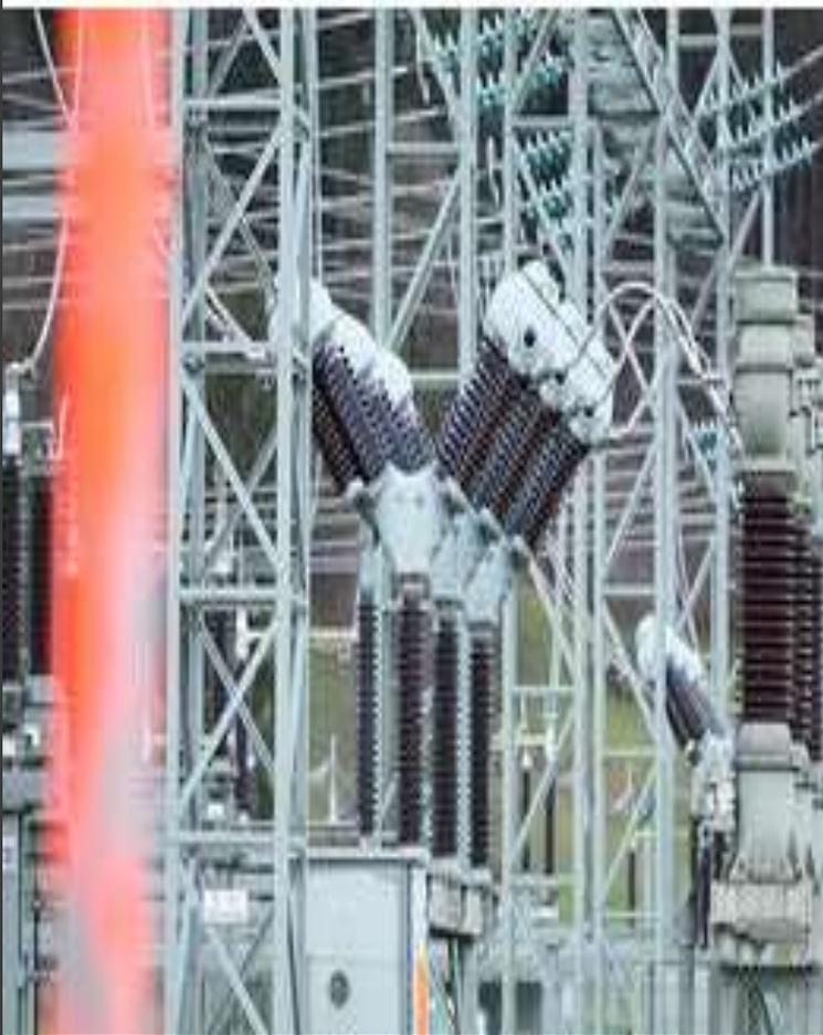
El interruptor de potencia es el dispositivo encargado de desconectar una carga o una parte del sistema eléctrico, tanto en condiciones de operación normal (máxima carga o en vacío) como en condición de cortocircuito. La operación de un interruptor puede ser manual o accionada por la señal de un relé encargado de vigilar la correcta operación del sistema eléctrico, donde está conectado.
