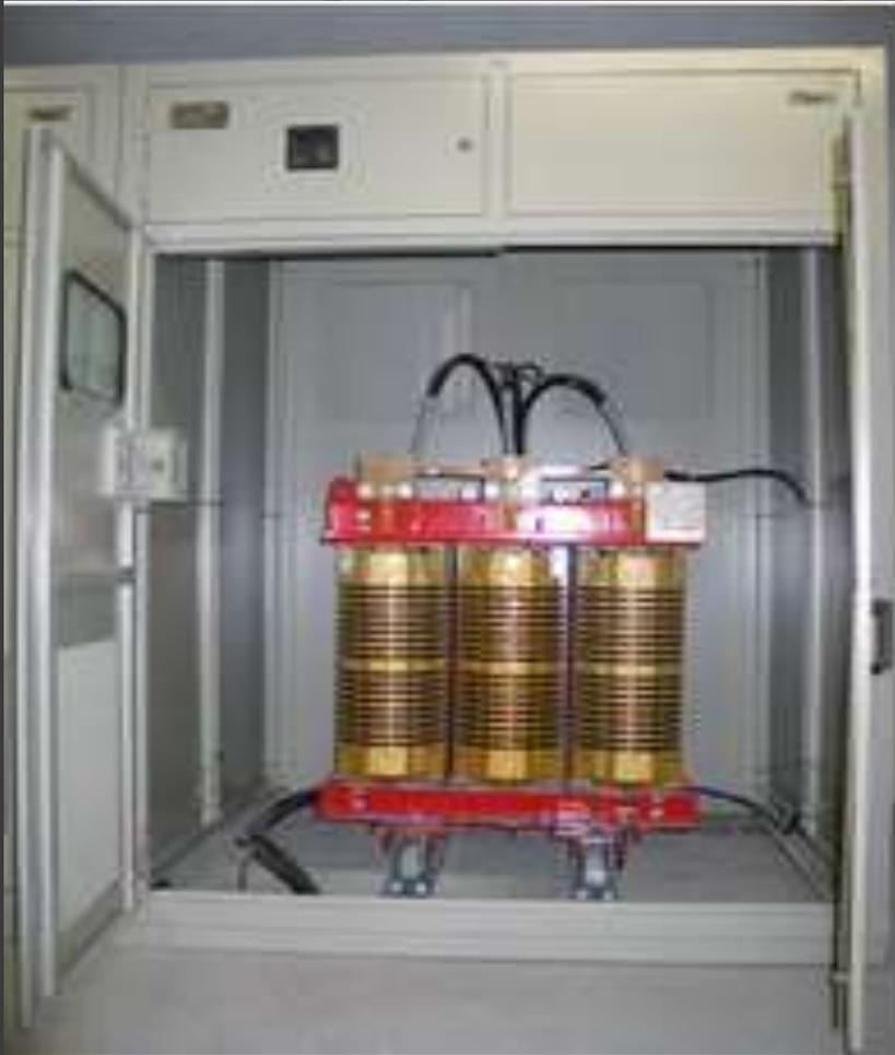
Las subestaciones o centros de transformación capsuladas, son aquellas en las que existe un recinto cerrado en el cual se encuentran alojadas varias celdas, una de ellas destinada para el transformador de distribución, una celda para el equipo de protección y maniobra, es decir el seccionador tripolar de trabajo bajo carga con nivel de aislamiento de 15 kV; otra celda alberga el grupo de medida compuesto por los transformadores de potencial y de corriente.
