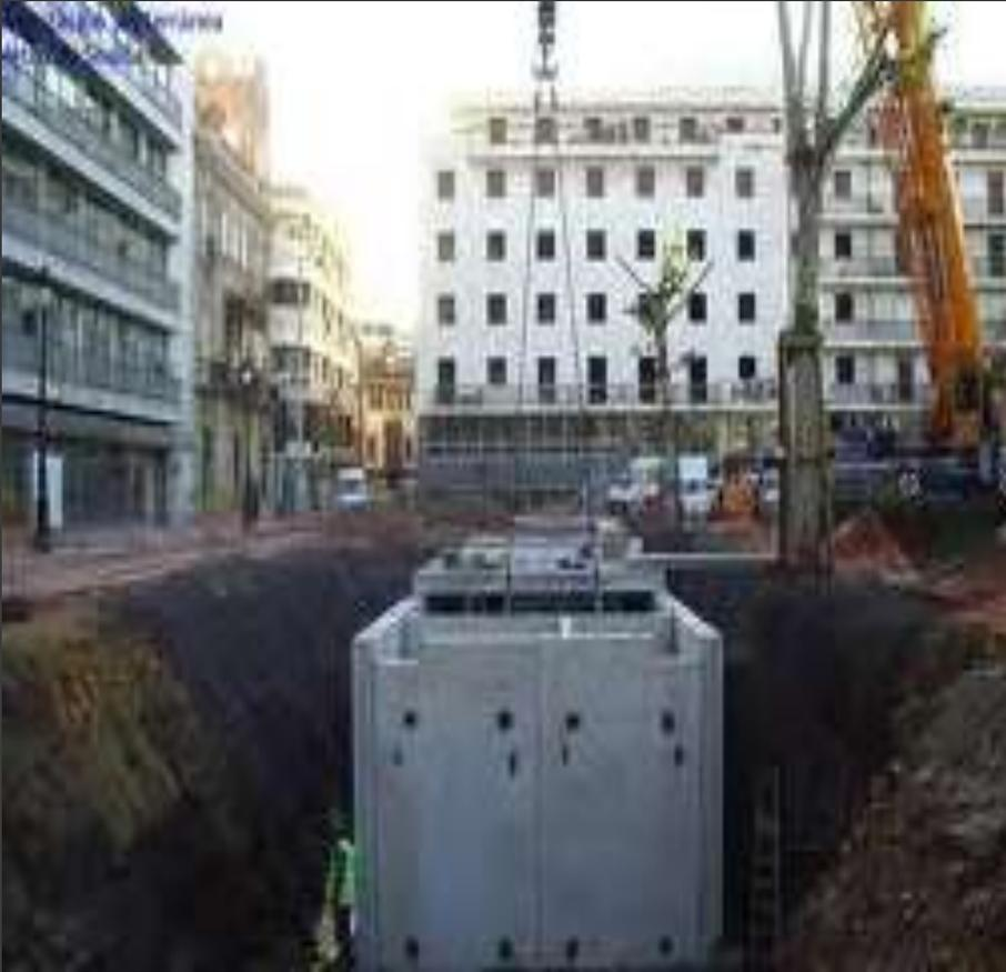
La subestación subterránea se instala bajo el nivel del piso en andenes, zonas verdes, o en un predio particular, están conformadas por dos bóvedas una para el transformador y otra para el seccionador de maniobras, estas se encuentran unidas por un banco de ductos. El seccionador debe ser de tipo inundable de operación bajo carga de 200 A, debe contar con codos premoldeados sin partes vivas expuestas, para la conexión de los terminales de media tensión.
