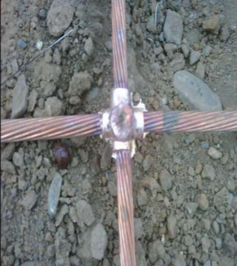
Los elementos que conforman el sistema de puesta a tierra deben soportar las condiciones ambientales del sitio donde están instalados, tener una mínima resistencia eléctrica y capacidad para soportar las corrientes de falla que se puedan presentar. Las conexiones de estos se realizan con soldadura exotérmica o conectores mecánicos aprobados.
