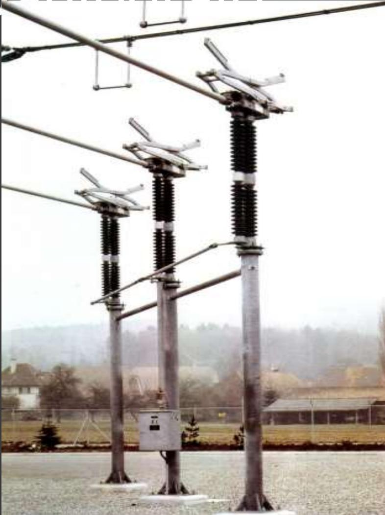
Los seccionadores de pantógrafo han sido creados para simplificar la concepción y la realización de las instalaciones de distribución de alta tensión en intemperie (se suelen utilizar para la conexión entre líneas y barras que se hallan a distinta altura y cruzados entre sí).
