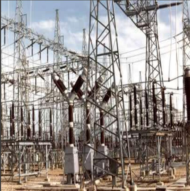
Es la subestación en la que se interconectan varios sistemas y de la cual se distribuye energía eléctrica a otras subestaciones o a otros sistemas, por esto lo mas importante es la flexibilidad de la subestación, la seguridad y la confiabilidad depende de la importancia que ejerza la subestación en el sistema de potencia.
